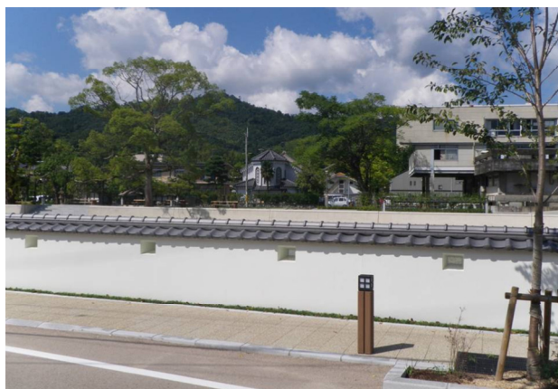
「しらかべのみち」は護岸の上に白壁の塀を設け、土色舗装とし、宮津城下の雰囲気再現
