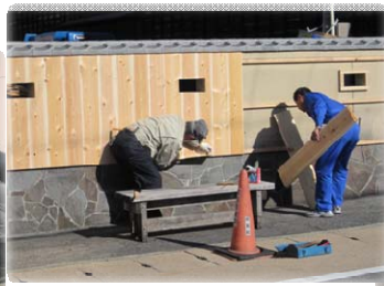
杉板貼り (この後、塗装作業へ)
