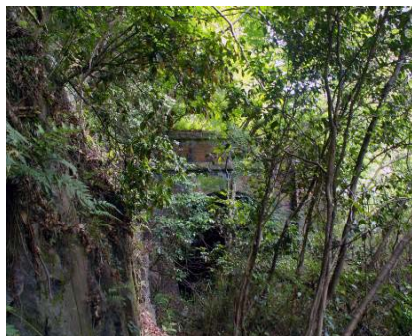
樹木に覆われた赤レンガ製トンネル
