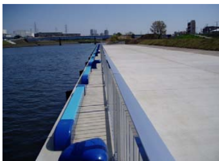
駒岡防災船着場
