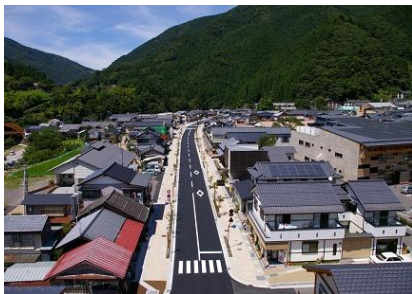
「国道440号まち中工区」の全景
