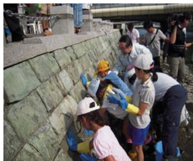
モルタルを塗った箇所への 青石護岸の張り付け
