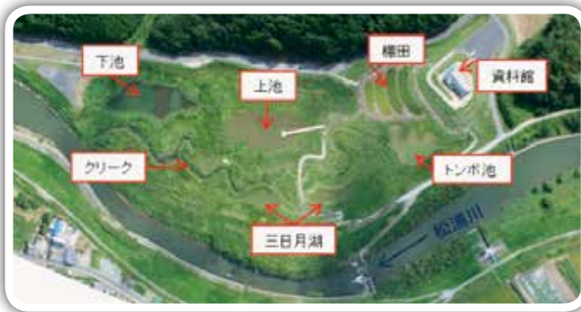
アザメの瀬全体写真
