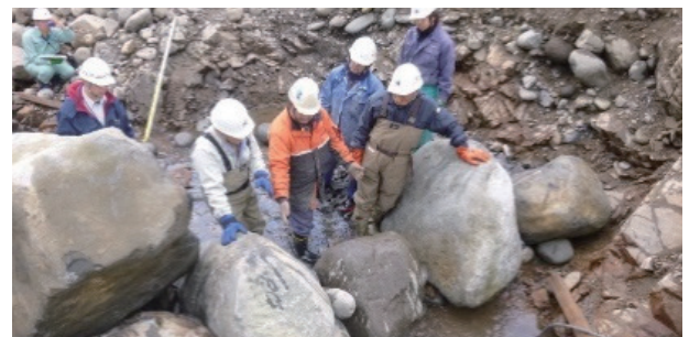
石組工法による分散型落差工の施工状況
