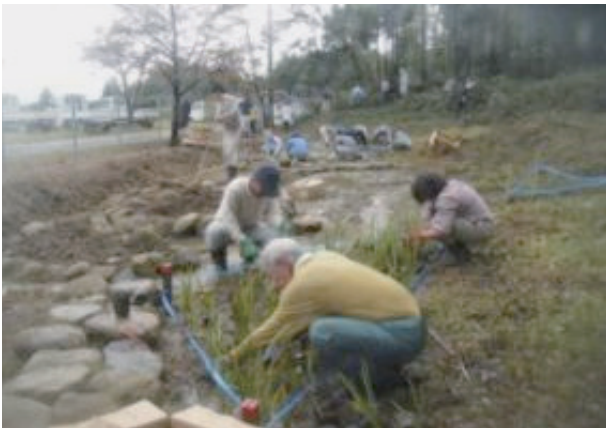
水生植物の植栽作業
