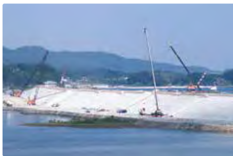
高田松原海岸 防潮堤工事
