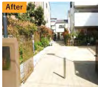
整備後の「ももに広場」
