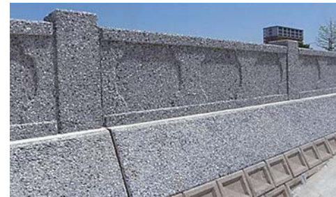
風治八幡宮の石の手すりのデザインを採用した堤防
