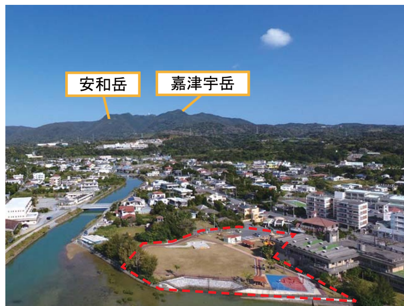
屋部支所管内地域振興会が計画策定段階より参画し、整備された屋部親水公園
