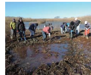
攪乱作業による湿地環境再生
