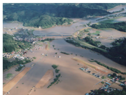
H14.7 台風 6 号による洪水被害 (北上川・砂鉄川合流点)
