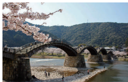
五連の木造アーチの錦帯橋
