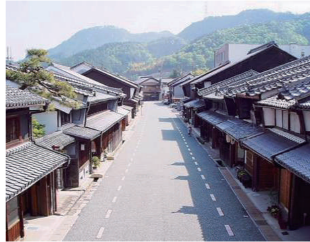
うだつの上がる町並 (電線の地中化、道路修景整備)
