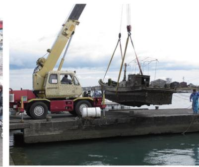
沈没船の引き上げ作業
