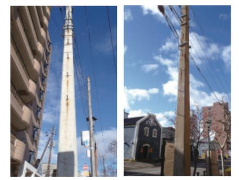
夫婦電柱 (現存する日本最古のコンクリート電柱)
