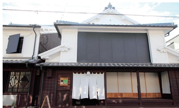
丸林本家北棟 修理後
