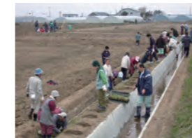
用水路へのハーブの 植栽の様子
