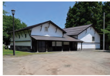
保存整備した2棟の浜倉(明治5年建築)
