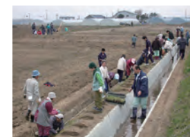
用水路へのハーブの 植栽の様子
