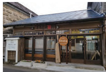
歴史的建築物 「利尻島の駅」の外観
