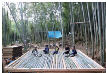
放置竹林に竹栈敷を整備
