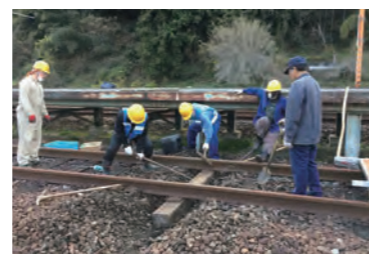
枕木の交換作業
