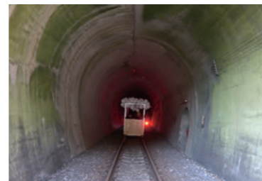
JRから譲り受けたトンネル
