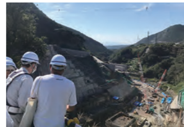
建設が進む様子
