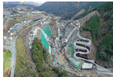
建設中の立野ダム
