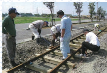
枕木、レールの敷設作業
