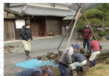
石積み水路の 補修ワークショップ
