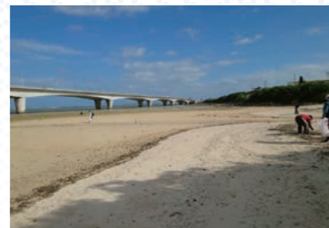
海没地区・カーミージー橋
