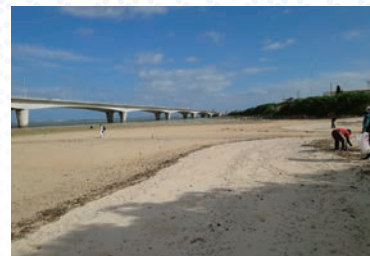
海没地区・カーミージー橋
