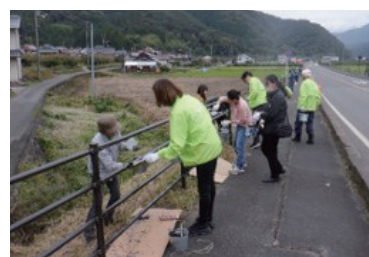
沿線のガードパイプを 「八頭ブラウン」に塗装
