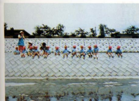
櫛形町の中心を流れる滝沢川は、南アルプスに源を発し富士川に合流している。天井川という地形のため洪水に悩まされることも多く、河川敷には雑草が繁茂しきの不法投棄などもあり、環境の悪い河川だった。しかし、改修事業を契機に環境整備を行い、高水敷にはサイクリングロード、園路、ベンチ、砂場、テニスコートなどを設け、芝で被覆し、植栽をした。低水路は底張りを施し、飛び石を配して対岸にわたれるよう配慮されている。また町のシンボルであるアヤメの花も植栽している。
