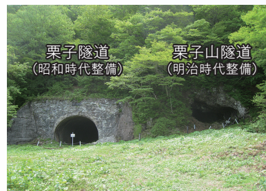
福島県と山形県の県境に整備された 栗子隧道 (山形県側)
