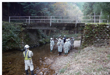
既存不適格橋を確認する 自治体職員
