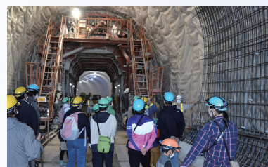
工事現場の見学
