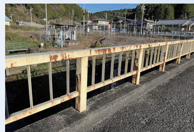
補修前の高欄の状況
