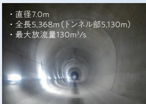
新日下川 放水路トンネル部
