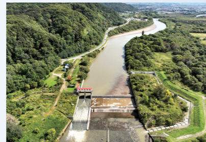
栗沢頭首工に整備された魚道(写真右側)
