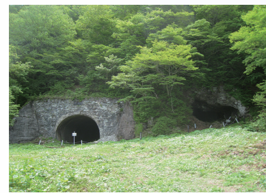
福島県と山形県の県境に整備された栗子隧道(山形県側)
