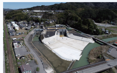
新日下川放水路呑口導水路
