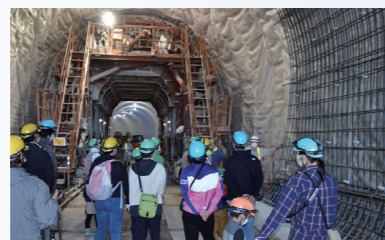
工事現場の見学
