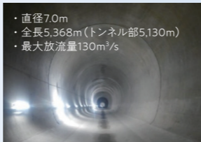
新日下川放水路トンネル部
