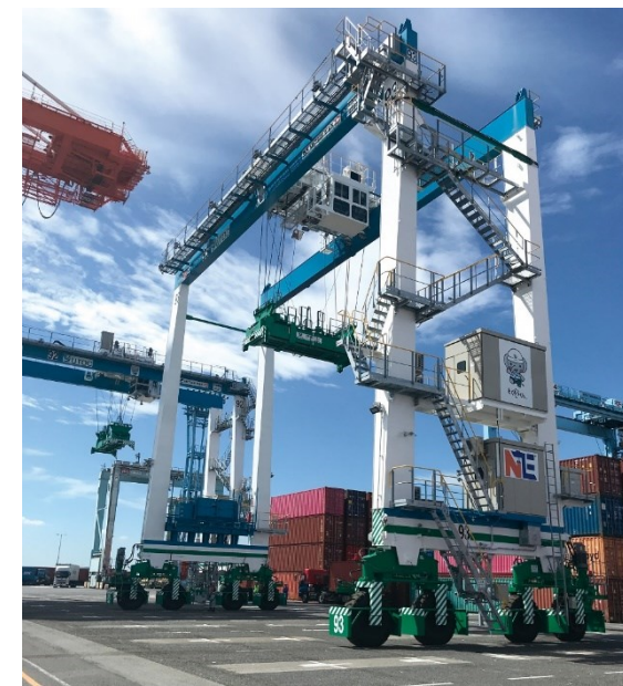
MC-2でのRTG稼働状況写真 (提供：(株)宇徳)
