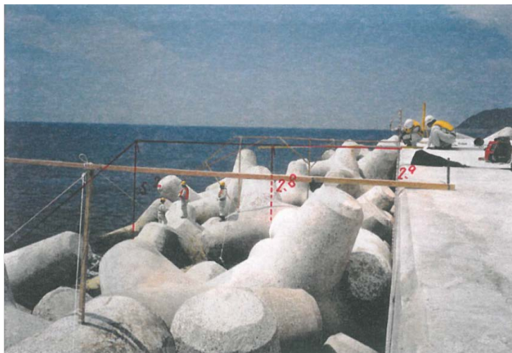
図 2.1 過去における消波ブロックの沈下量の直接計測
