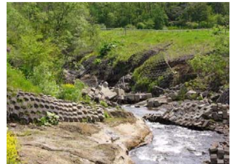
川底が削られた河川 (拡幅による流速低下策や河床安定のための の工作物設置を計画)
