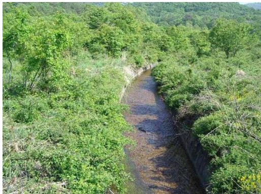
乾燥化の一因の コンクリート三面張水路
