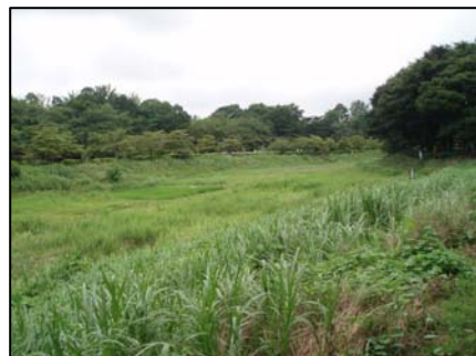
野川第一調節池（東側）
