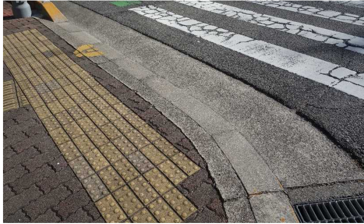
図 3. 8 段差が解消された歩道部と横断歩道の境界
