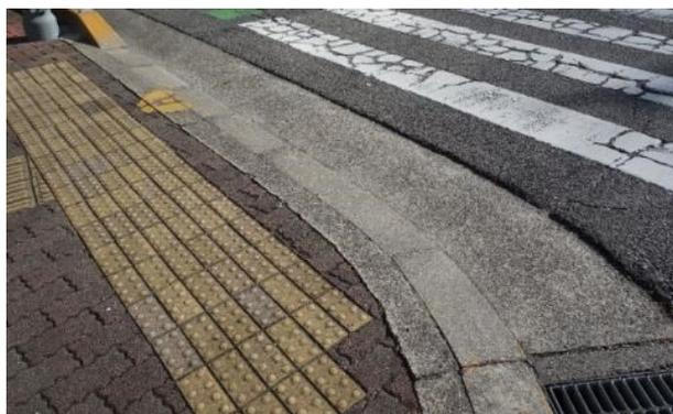
図3. 9 段差が解消された歩道部と横断歩道の境界
