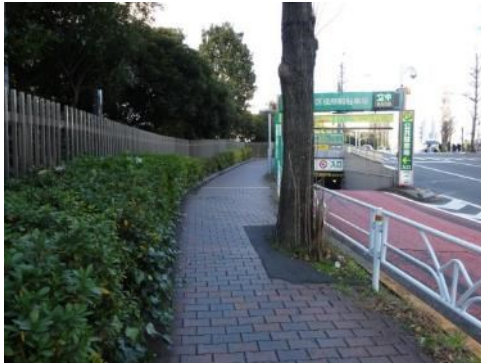
図3. 4 車道と歩道の物理的な分離ありの例
