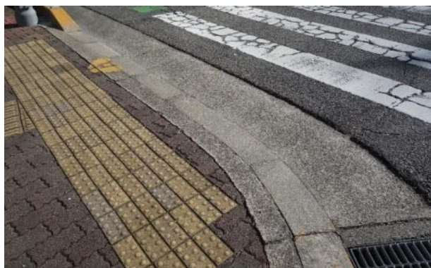
図 3. 9 段差が解消された歩道部と横断歩道の境界
