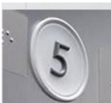
図 3. 4. 6 エレベーター（籠内）の操作盤における文字の浮き彫りによる表示例
