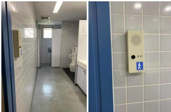
図 3. 4. 1 トイレ内側の音声案内装置の設置例
