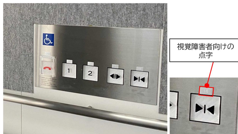
図3. 3. 1 車椅子使用者及び視覚障害者に対応した操作盤の設置例
