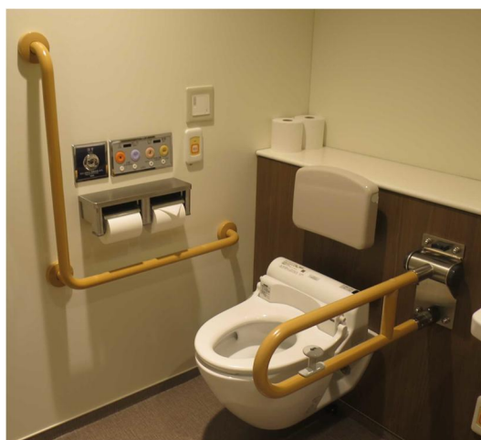
図 3. 4. 3 便座の手すりの設置例
