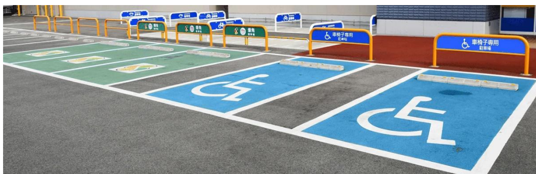
図 3. 3. 19 車椅子使用者用駐車施設、優先駐車区画の案内表示例
