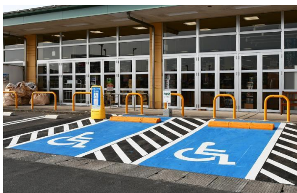
図3. 3. 35 車椅子使用者用駐車施設の設置例
