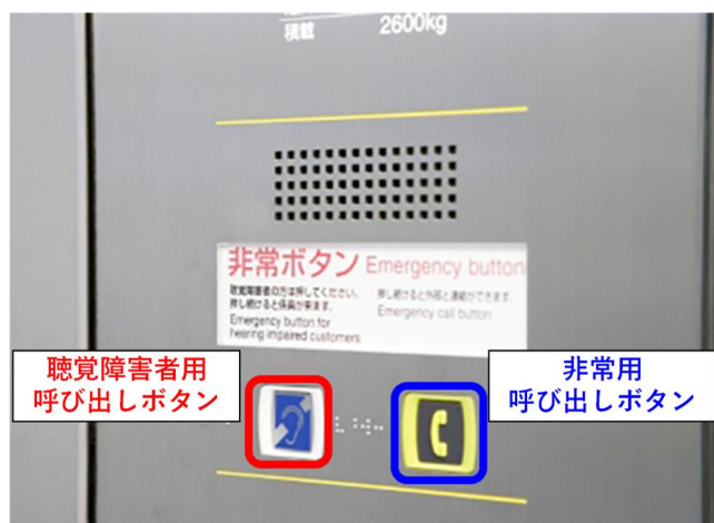
図 3. 4. 8 非常用呼び出しボタンの設置例
