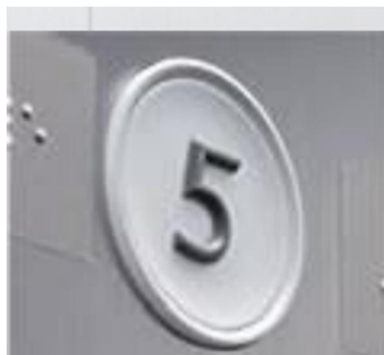
図 3. 4. 6 エレベーター（籠内）の操作盤における文字の浮き彫り例
