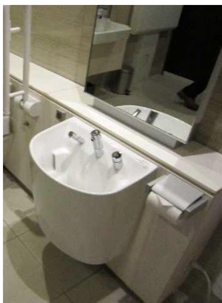
図 3. 3. 8 オストメイト用設備の設置例
