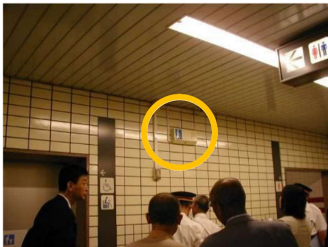
図3. 3. 33 トイレでの音声案内の例(人感知式)
