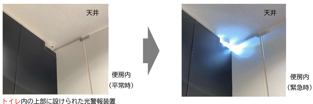
図 3.3.31 光警報装置の設置例
