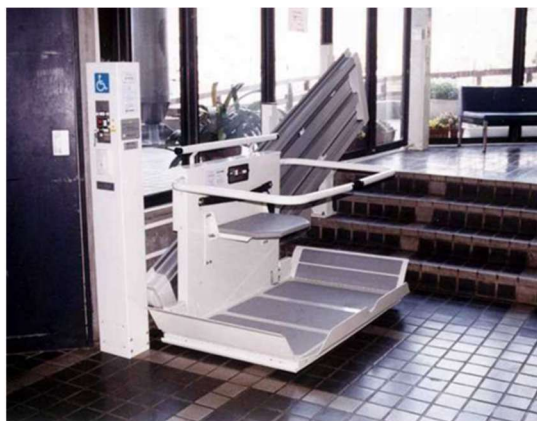
斜行型段差解消機
