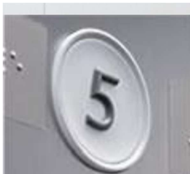
図 3.4.6 エレベーター(籠内)の操作盤における文字の浮き彫り例
