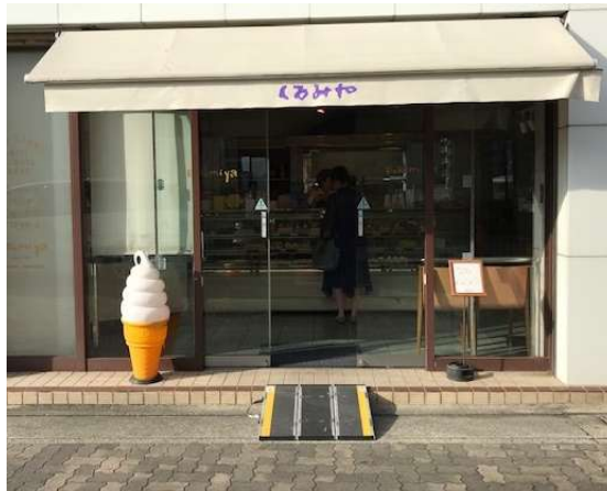
図3. 4. 18 車椅子用可搬型スロープの設置例
