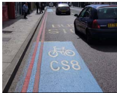
全線ブルーカラー舗装
