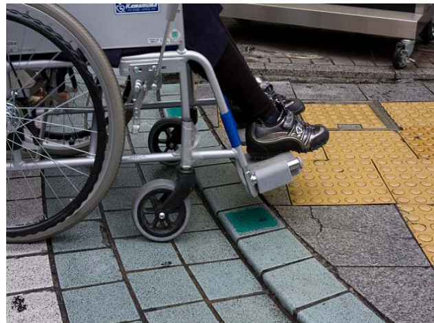
歩道上の段差
