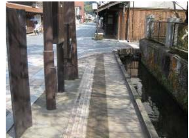
蓋のない水路、支柱による狭さく部
