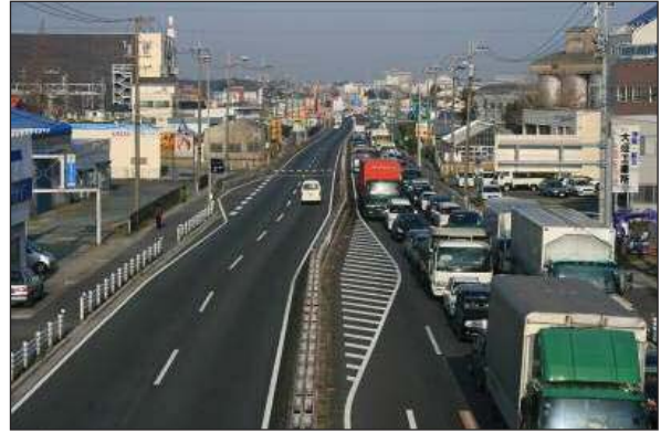
県境地域（国道1号：豊橋市大岩町）
