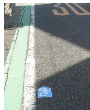
ラチエン通りに敷設されている 自転車ナビシート
