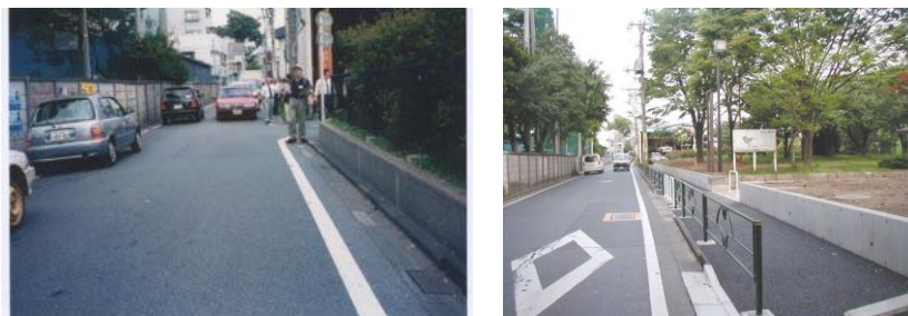
祖師谷公園の園路整備
