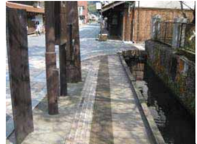
蓋のない水路、支柱による狭さく部
