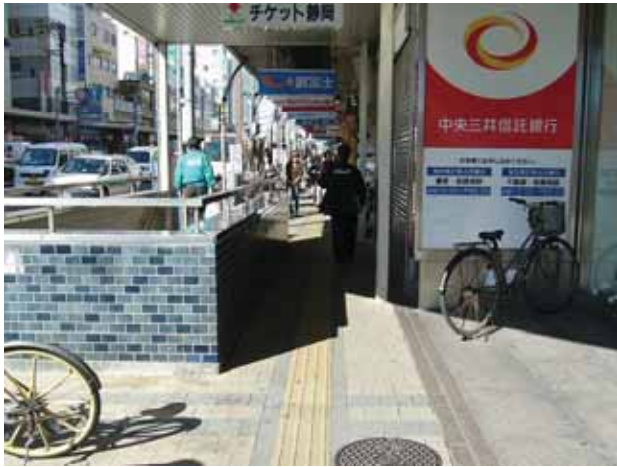
幅員狭小の区間
