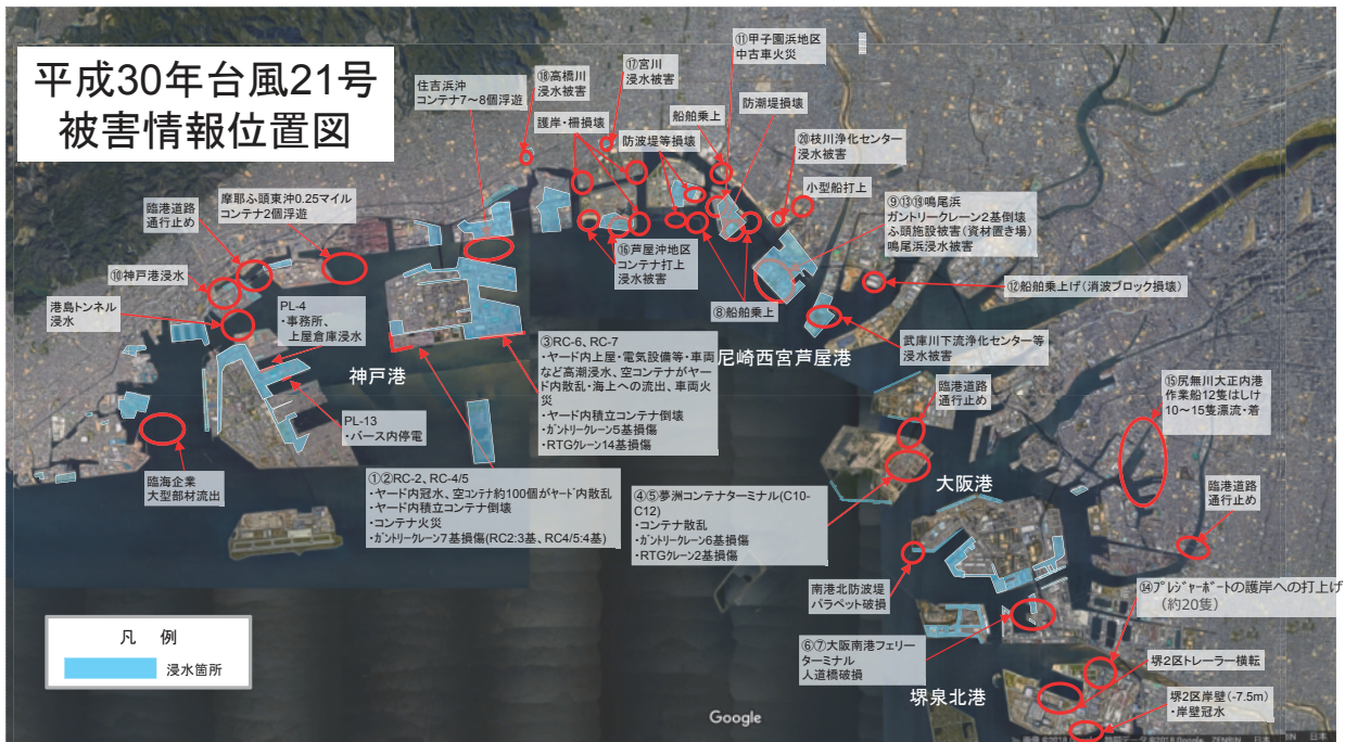
図表1-2-2-17 台風第21号による神戸港の被害状況
