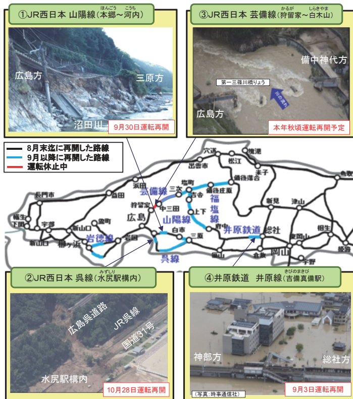
図表1-2-2-14 平成30年7月豪雨による鉄道の主な被害状況 (2019年5月時点)
