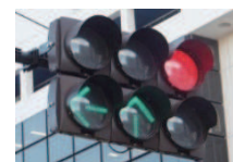
信号機の多現示化
