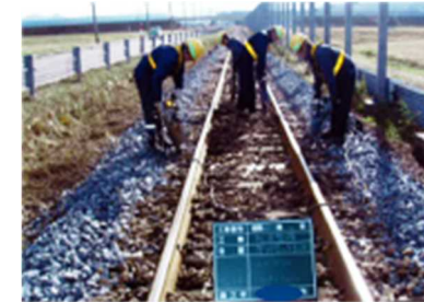
レールの修繕
