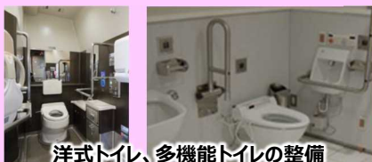
洋式トイレ、多機能トイレの整備
