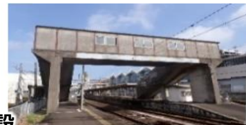
既存施設の 撤去
