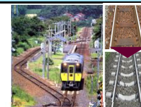
軌道強化による高速化
